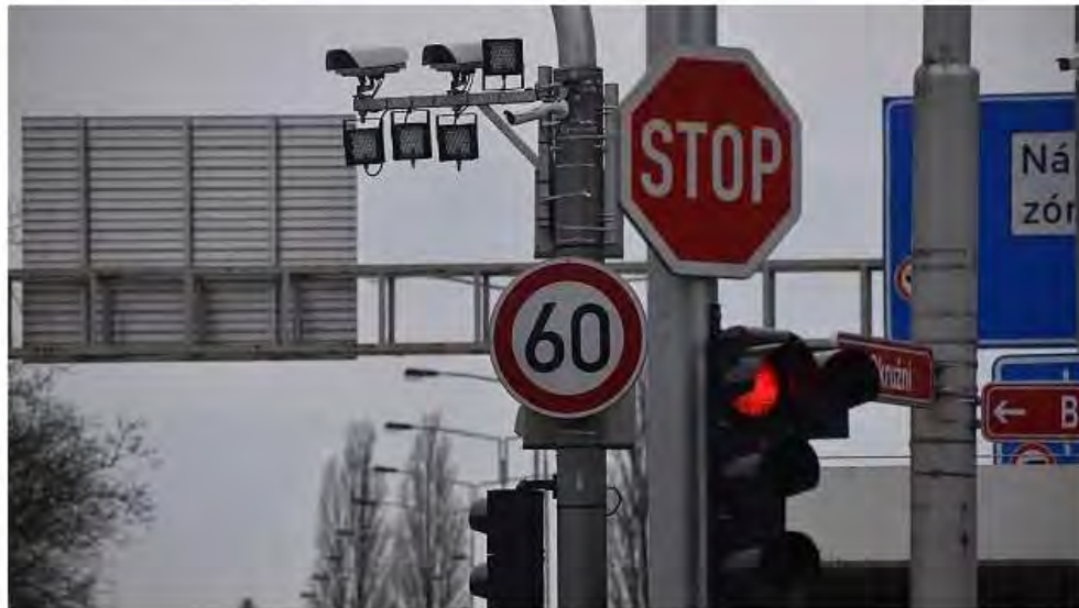
Součástí Inteligentního dopravního systému v Hradci Králové jsou také radary a kamery. | Foto: Deník/Liří Fremuth
